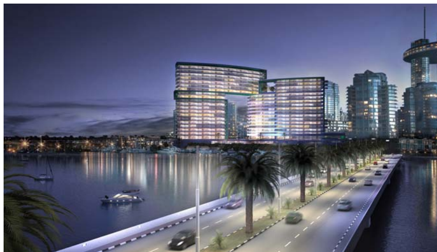
Proyecto Damac Properties. Abu Dhabi. Emiratos Arabes
